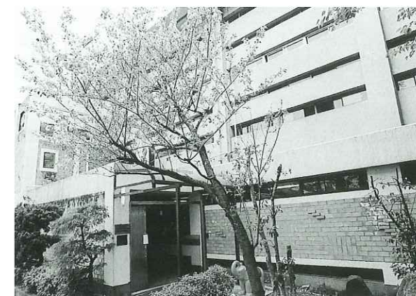
●昭和39年 總持寺母子寮新築工事
