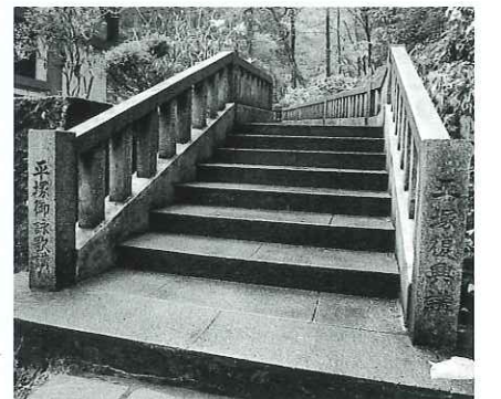
●昭和53年 大雄山最乗寺参道石垣工事
