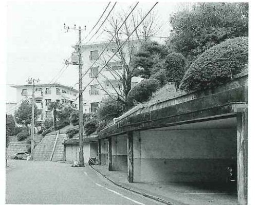
●昭和38年 總持寺分譲アパート新築工事
