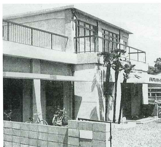
●昭和37年 精舎幼稚園新築工事 本山社会事業部孤児養護施設「精舎幼稚園」園舎及びホール落成。
