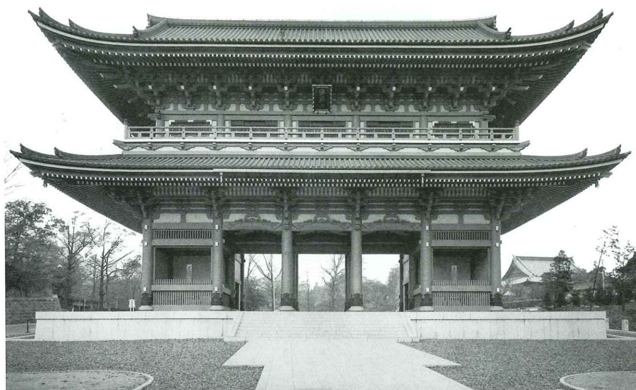
●昭和42年 總持寺三門建立敷地基礎事業 鉄筋では日本一の門で、昭和44年に木原崇雲氏の一寄進で建立されたもの。なお三門楼上には、観音菩薩、四天王、十六羅漢が祀られている。
