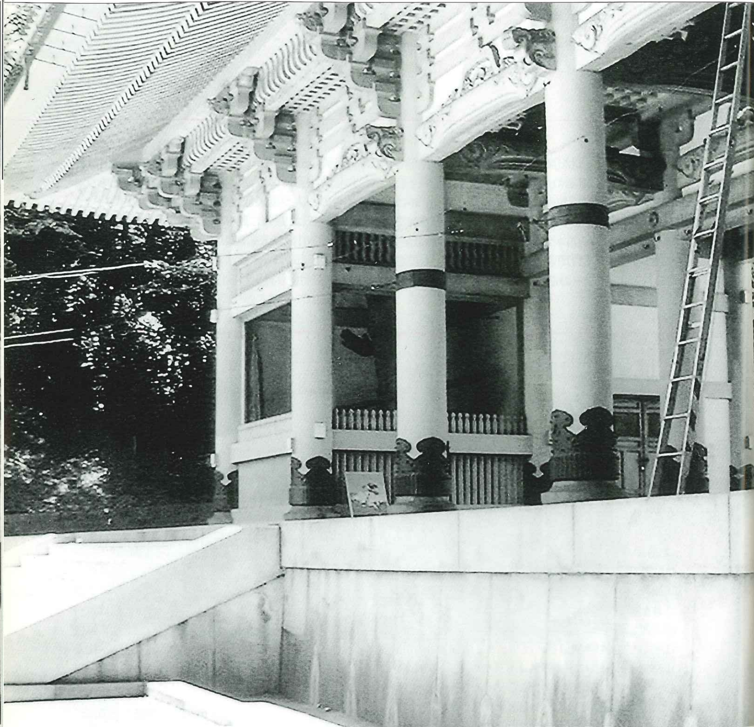
●山門(三門)建立敷地造成工事
