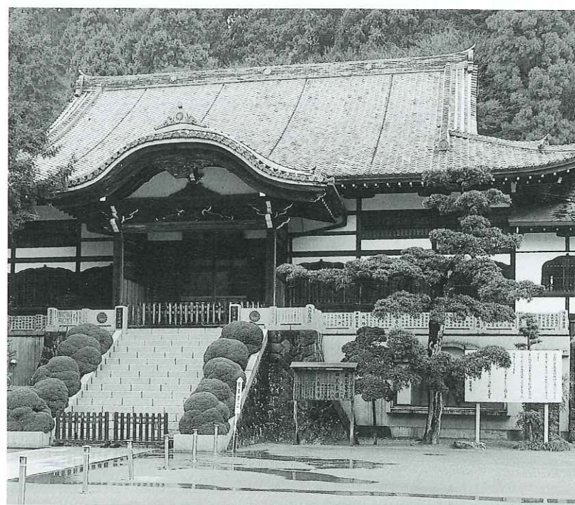
●昭和31年 大雄山最乗寺書院新築工事
