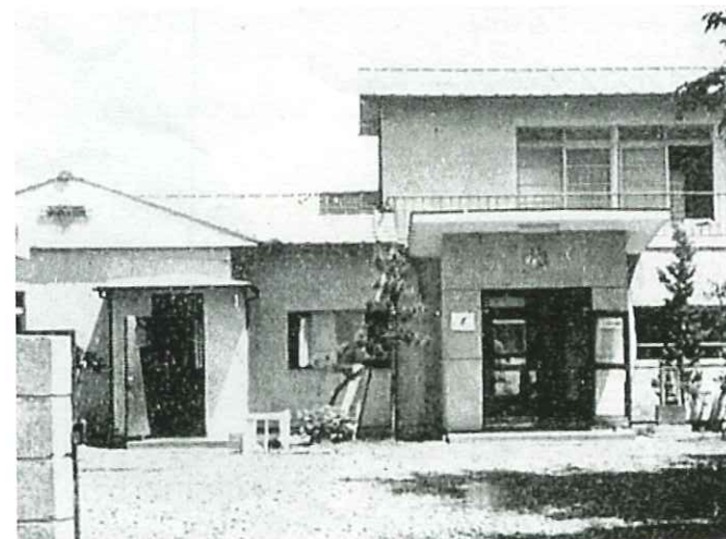
●昭和37年 精舎幼稚園新築工事
